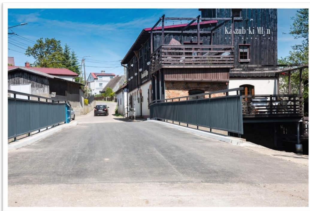
ZDJĘCIE: MOST W CIĄGU UL. MŁYŃSKIEJ W WIERZCHUCINIE
