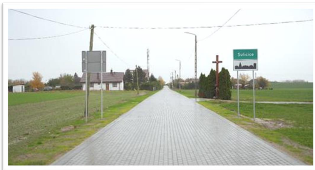
ZDJEĆIE: REMONT DROGI W SULICICACH WRAZ Z BUDOWĄ KANALIZACJI SANITARNEJ I ODWODNIENIA
